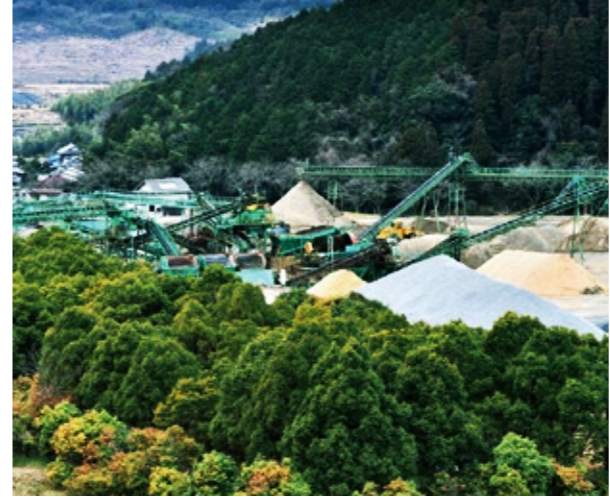
ヤスミ資材(株)の緑化エリア(手前)
