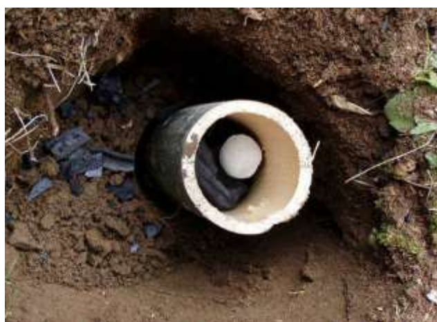
掘削穴に砕木炭+籾殻+緩効性肥料を入れる。周りは掘削残土と土壌改良材を混ぜて覆土とする
