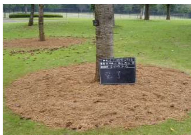
空気管埋設後は、敷き藁、バーク堆肥、腐葉土等でマルチングを行う
