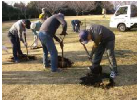
空気管の埋設作業(冬期)
