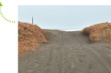
人や車が通るために砂丘が削られていた部分から津波が押し寄せたため、左右と同じ高さまで砂を入れた。今後緑化を行う予定（白子町・五井海水浴場）
