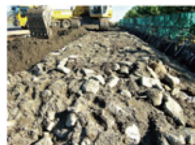
一層1mほど掘り下げ、ガレキ交じりの土砂を投入
