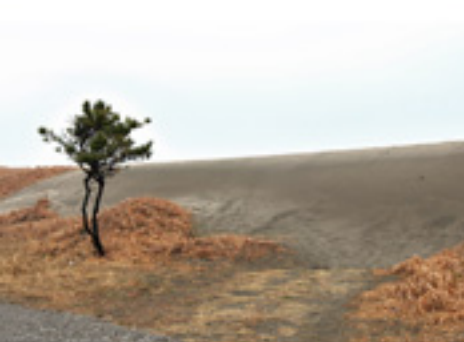
被災した松を伐採した後、新たに台形に盛土を整備。この上に植樹することで、防波の役割も果たすこととなる（旭市様）
