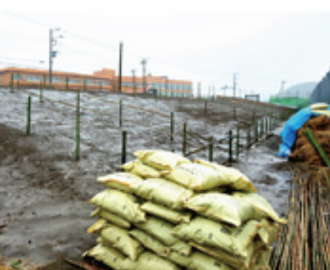
被災した松を伐採した後、新たに台形に盛土を整備。この上に植樹することで、防波の役割も果たすこととなる（旭市様）
