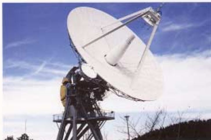
▲直径18mもあるUSB(F)-1/136MHz帯送受信アンテナ。勝浦追跡管制所にある稼働中の2機のパラボラアンテナのうち1機で、おもに中高度衛星(同回衛星)との送受信に使われている
